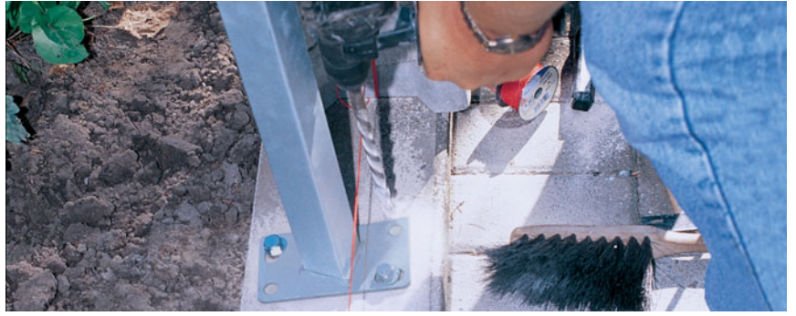
oder mit Pfostenträger aufschrauben.
