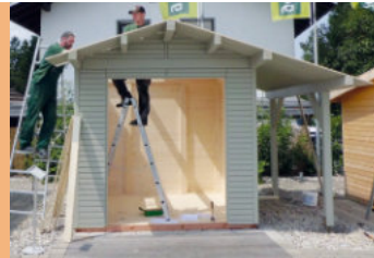
Erstellung der Dachschalung
