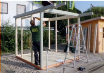
Aufbau der Skelettstruktur
