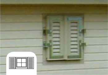
Fenster mit o. ohne Klappläden
