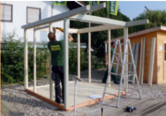
Aufbau der Skelettstruktur
