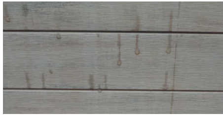
Fleckenbildung durch von Regen angelöste Partikel
